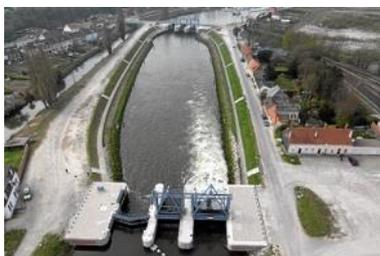
En complément de leur rôle d'ouvrage de garde et de régulation hydraulique, conformément à la législation en vigueur, les ouvrages de Saint-Valery-sur-Somme doivent assurer la continuité biologique par une gestion adaptée des vannes du barrage supérieur et du barrage inférieur.
