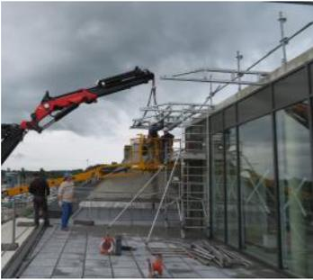
Le ravalement des façades intérieures et extérieures est terminé. La mise en place de la casquette du bâtiment a débuté courant juin et devrait être terminée début juillet. Il s'agit d'une petite couverture en avancée protégeant les baies vitrées. Les autres chantiers se poursuivent (cloisons, carrelage, peinture, réseaux techniques,...).
