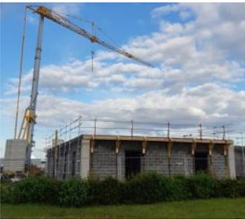
Dès juillet, les travaux d'étanchéité de la toiture débuteront et les menuiseries seront posées. Après ces deux étapes, et sauf exceptions, les travaux de second œuvre (passage des réseaux, cloisonnement et finitions) pourront débuter.
