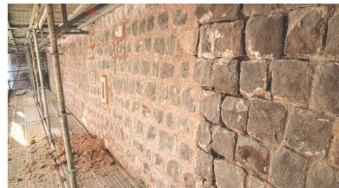
Fin juin, les équipes ont terminé les forages et le renforcement des remparts jusqu'au parvis de l'église. Cela a rendu l'accès au chemin de ronde entre l'escalier couvert, la tour de l'échevinage et la place Saint Martin. Le rejointoiement et la reconstitution des parements se poursuit permettant le déplacement de l'échafaudage.
